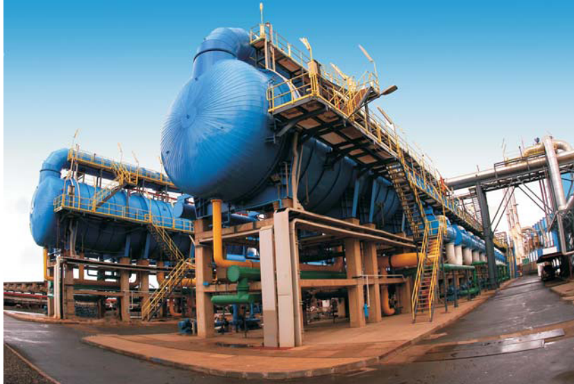
Vista general de la planta
