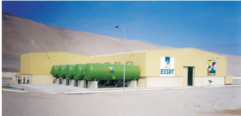
Vista general de la planta
