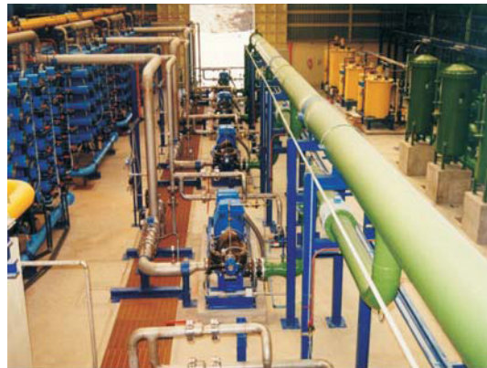
Nave de proceso
