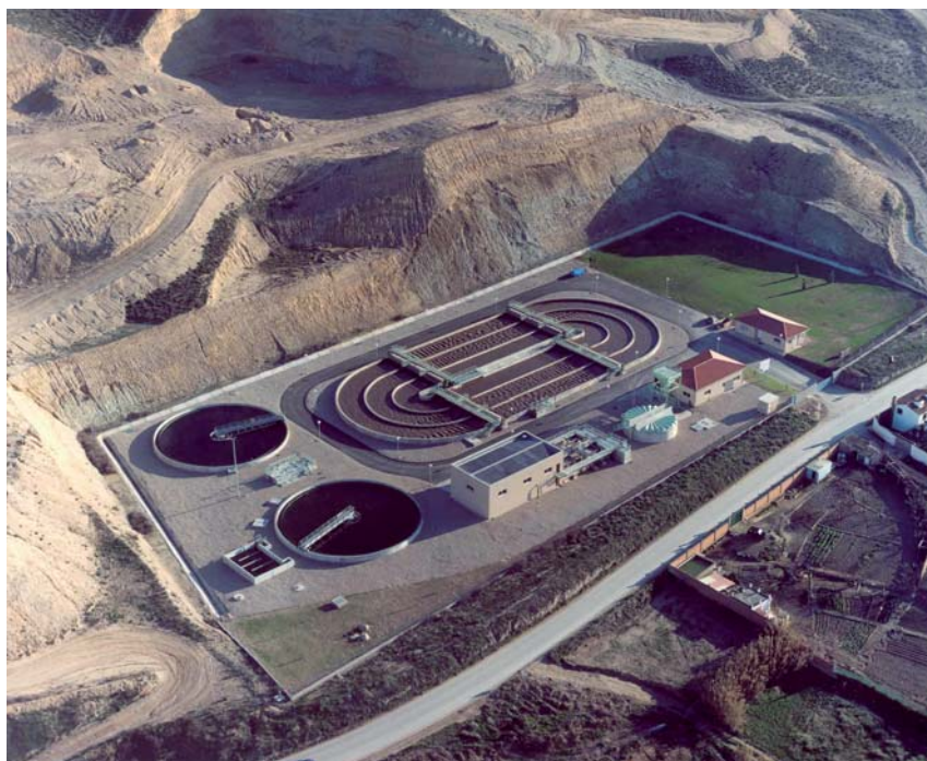
Vista general de la EDAR
