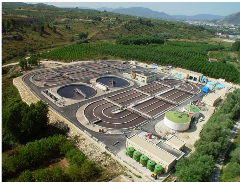
Vista general de la EDAR
