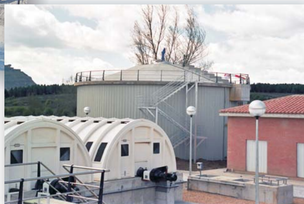
BIODISCOS Y ESPESADOR
