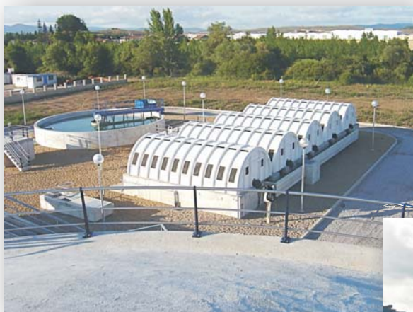
BIODISCOS Y DECANTADOR
